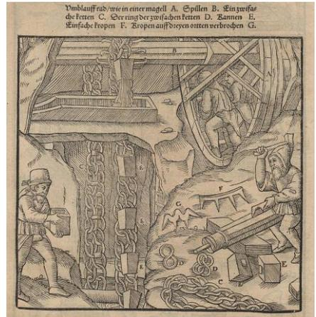
der Wasserhaltung konnten Grubenbaue mit Teufen von 20 bis 30 Metern unter dem jeweiligen Stollen entwässert werden. Allerdings war für diese Art der Wasserhaltung ein hoher Bedarf an Wasserknechten erforderlich. In einigen Bergwerken waren oft mehr Wasserknechte mit der Wasserhaltung beschäftigt als Hauer vor Ort waren.
